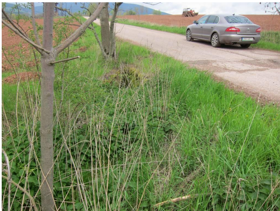
Obr. 47: Pohled na zanesený nedostačující trubní propust pod PC16
