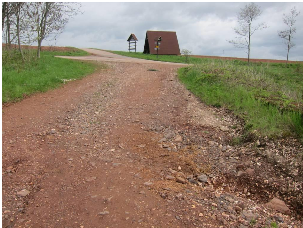
Obr. 48: Pohled na nedostatečné řešení odvodnění cesty
