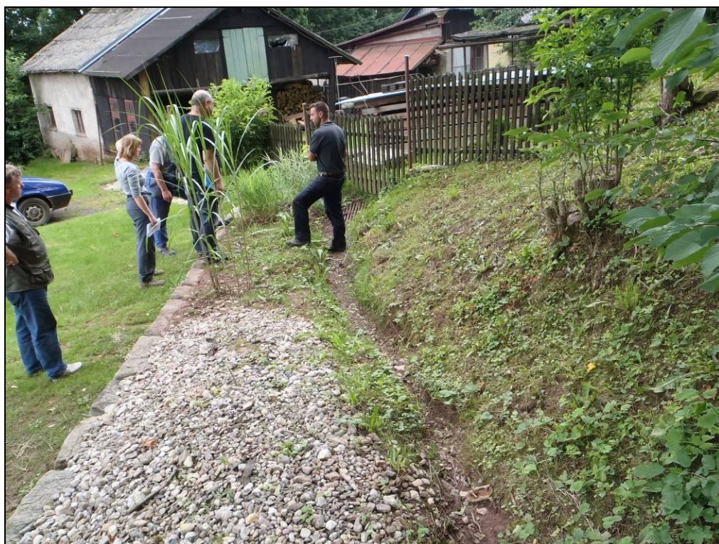
Foto č. 7. Záchytný a svodný kanál v subpovodí č. 3 je třeba prohloubit a opevnit dno a patu.
