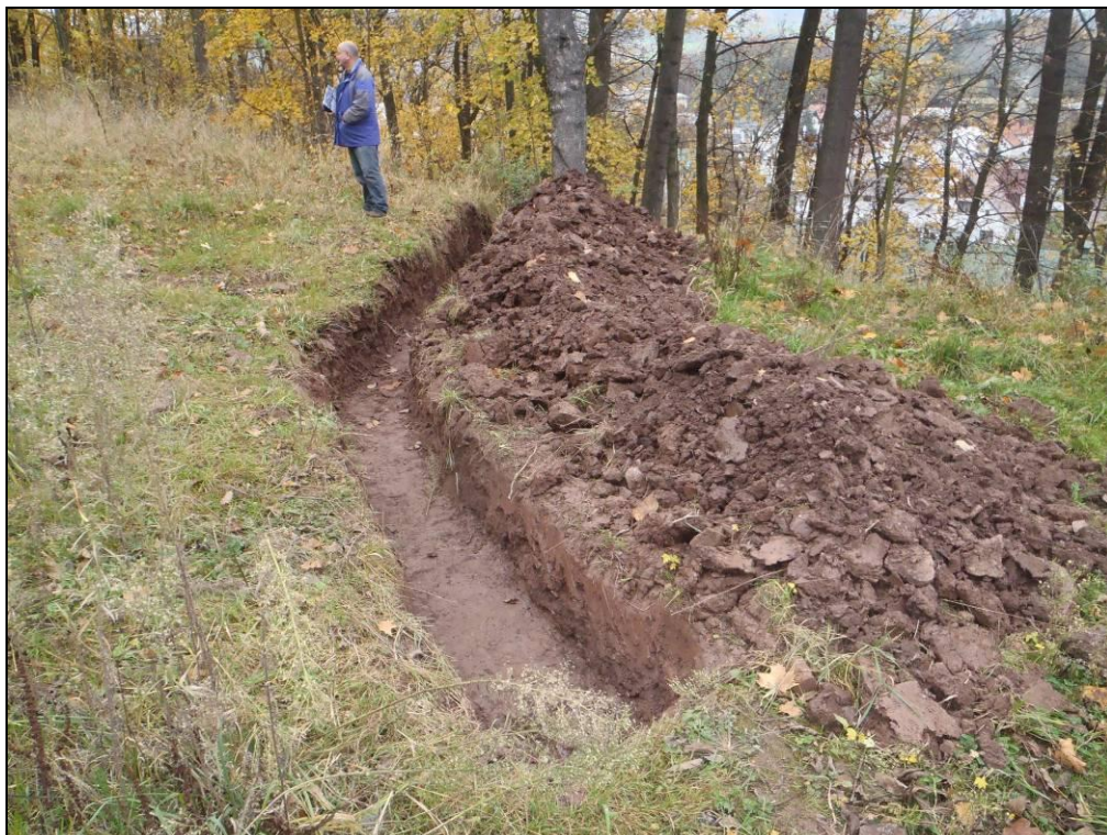
Foto č. 8. Záchytné příkopy uměle přerušují povrchový odtok. Tyto opatření je nutné provádět koordinovaně a komplexně.
