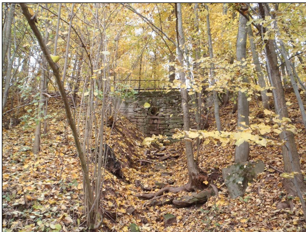
Foto č. 1. Záchytný příkop podél příjezdové cesty v subpovodí č. 1, který je zaústěn do cestního propustku, je nutné opevnit a tím i stabilizovat opěrnou kamennou zídou.
