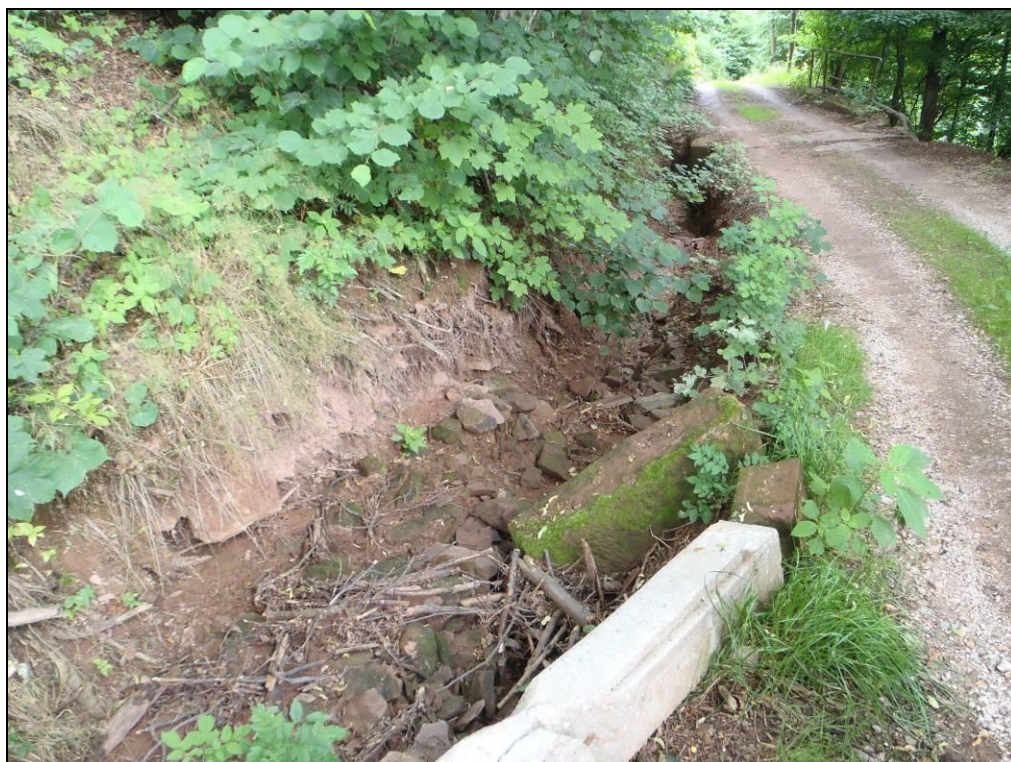
Foto č. 1. Záchytný příkop podél příjezdové cesty v subpovodí č. 1, který je zaústěn do cestního propustku, je nutné opevnit a tím i stabilizovat opěrnou kamennou zídou.
