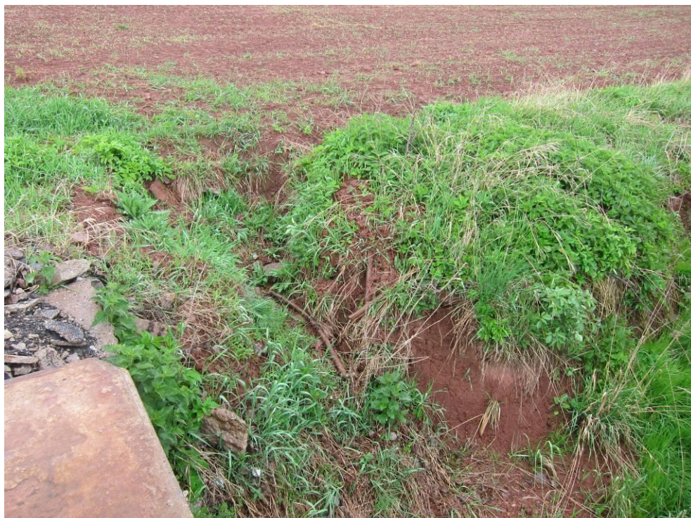
Obr. 45: Erozní rýha při napojení PC49 na PC46
