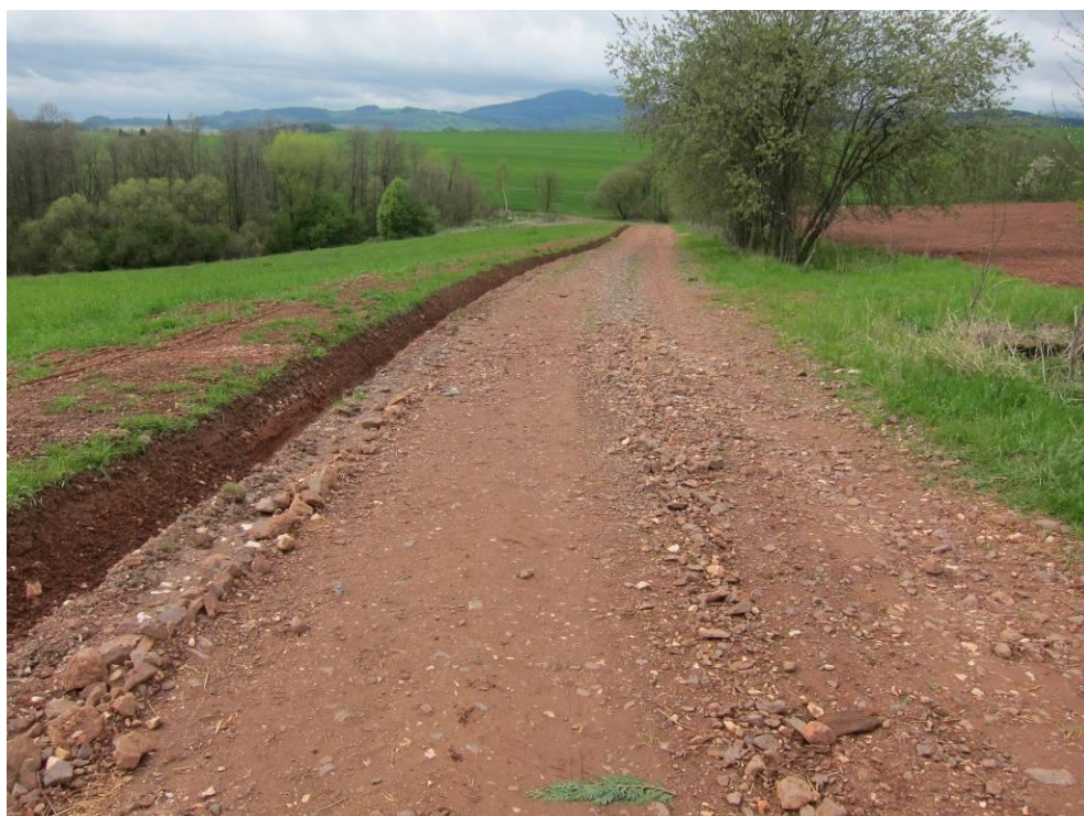
Obr. 49: Pohled na stávající příkop nedostatečných parametrů a bez stabilizace dna
