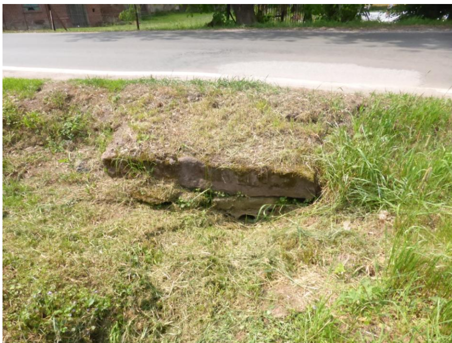
Obr. 17: Pohled na „propustek“ stávající ze dvou trubek DN200
